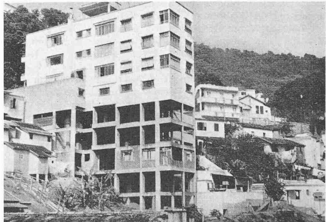
Viergeschossige Bauweise am Hang mit Betongerüsten als Unterbau im ehemaligen Villenviertel Sta. Teresa
