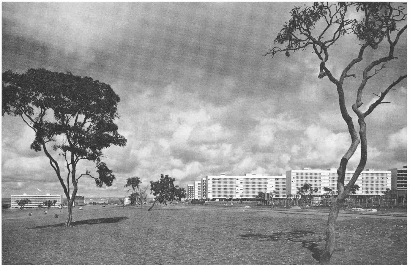
Wohnviertel Brasílias mit sechsgeschossigen Einheiten
