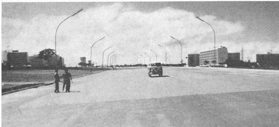
Die mittlere Fahrbahn der Hauptstrasse, 7 Spuren
