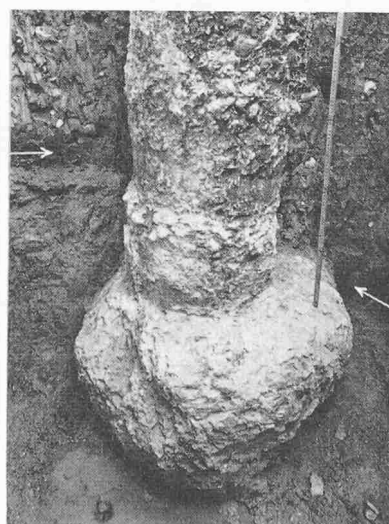
Bild 4. Ausgegrabener Frankipfahl Krankenhaus «Obere Waid», Zürich (Photos H. Wolf-Bender's Erben)
