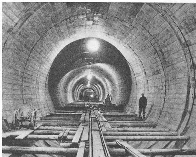
Bild 5. Blick in den fertigen Stollen von 8,35 m l. Weite (Photo BAWAG)
