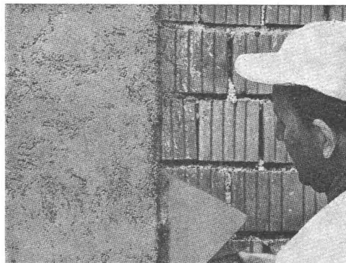
Gleicher Mörtel, nur mit TRICOSAL-WA hergestellt, haftet besser und lässt sich zügig verarbeiten.
