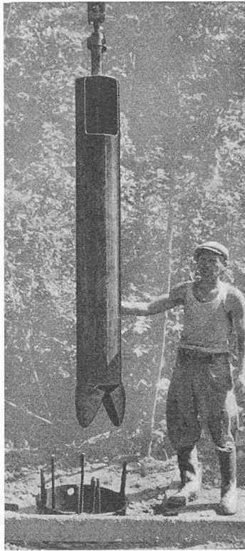
Bild 3. Betonbenne über dem Bohrröhre
