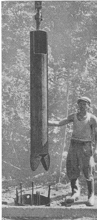
Bild 3. Betonbenne über dem Bohrloch
