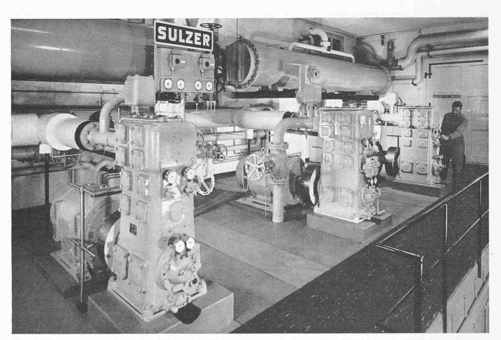
Bild 2. Kälteerzeugungsanlage mit drei ölfreien Sulzer-Kolbenkompressoren mit einer Normalkälteleistung ( $-10/+25^{\circ}$  C) von insgesamt 800 000 kcal/h
