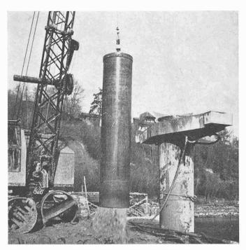
Bild 3. Kies- und Schlammpumpe HW beim Entleeren
