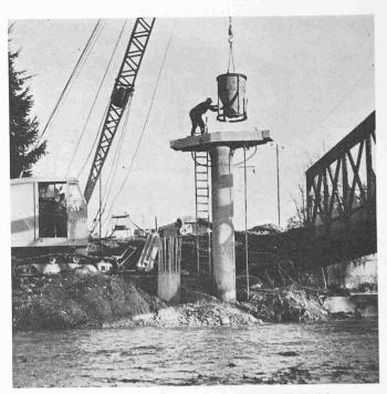
Bild 9. Bau eines Pfahljochs für eine Eisenbahn-Notbrücke
