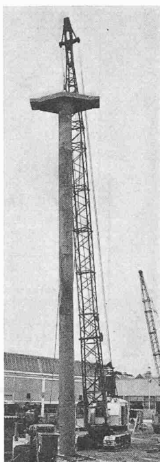
Bild 1 (links). Versetzen eines 25 m langen Bohrrohrs
