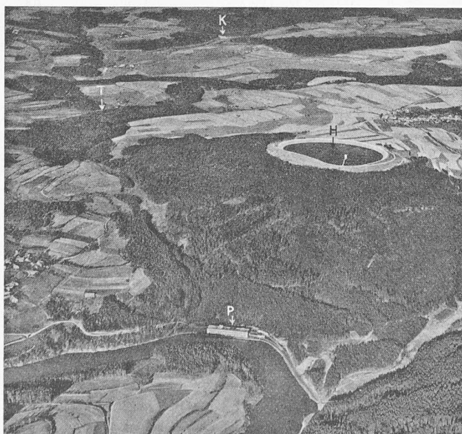
Bild 3. Reisachwerk mit Hochspeicher Rabenleite H, Pumpspeicher-Krafthaus Reissach-Rabenleite P, Krafthaus Tanzmühle T und Kainzmühlensperre K.
