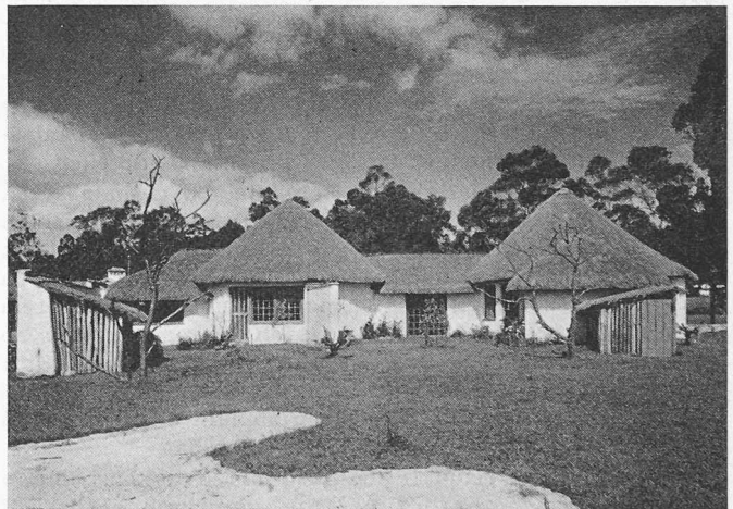
Die Kindergartenpavillons, Südansicht
