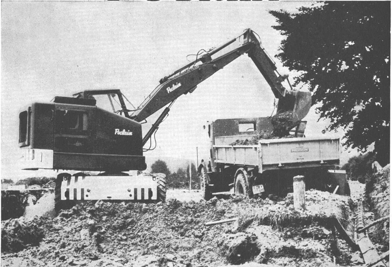
Unser Bild: Verladearbeiten im Strassenkoffer
