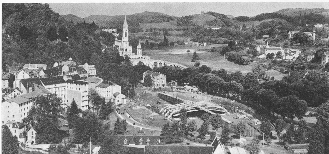
Die Baustelle der Basilika St. Pius X. in Lourdes. Im Mittelgrund die neugotische Kirche bei der Wundergrotte. — Photos H. Baranger, Paris
