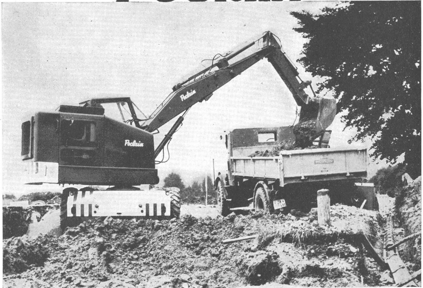
Unser Bild: Verladearbeiten im Strassenkoffer
