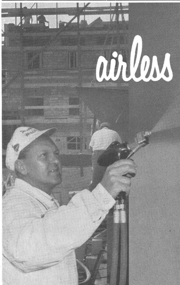
Mit dem Airless-Spritzstrahl kann fast wie mit dem Pinsel abgegrenzt lackiert werden, weil wenig Spritznebel entsteht, d. h. kein Ueberspritzen erfolgt.
