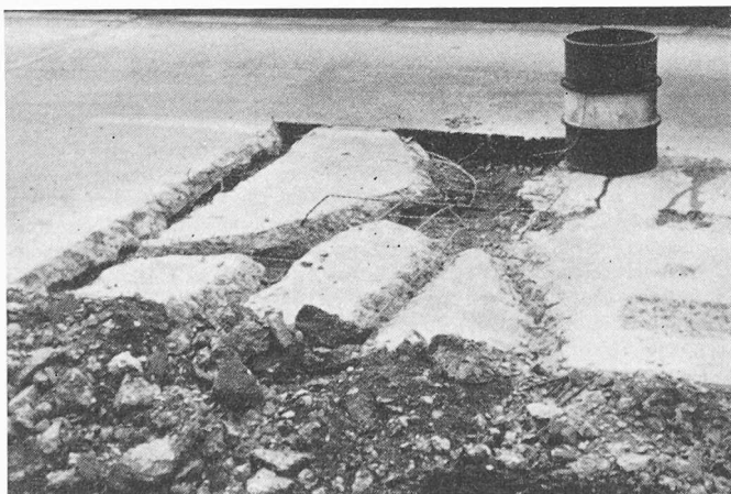
Bild 6. Fahrbahnplatte der Bundesautobahn nach dem Entfernen des losen und beschädigten Betons und Säubern der Flächen des alten Betons mit Druckluft und Wasser. Rechts bis auf den Unterbeton ausgestemte Verschleisschicht
