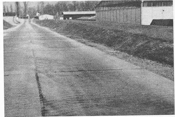
Bild 5. Prüfstrasse gemäss Bild 4 nach der Instandsetzung der Fahrfläche und nach über einjähriger starker Benutzung durch schwerste Kettenfahrzeuge. Die Riffelung auf der Betonoberfläche ist durch den Stollenabrieb bedingt
