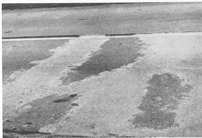
Bild 7. Platte von Bild 6 nach der Instandsetzung: Anspritzen der alten Betonflächen mit Colgrout, Schliessen der Risse mit Rollkies 15/30 mm \varnothing und Colcrete-Spritzbeton lagenweise eingebracht und Einstreuen von Splitt in die Oberfläche für die Verschleisschicht (Ansicht nach Benutzung durch den Verkehr)
