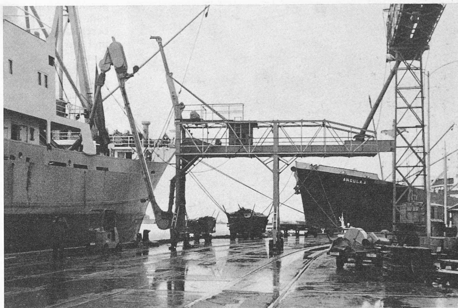
Bild 7. Die eigentlichen Belademaschinen sind auf pneumäderbereifte Stahlgerüste aufgebaut. Diese können nach Beendigung der Operation beiseitegestellt werden, um Platz für andere Umschlagsgüter zu schaffen (Anlage in Haifa wie Bild 6)
