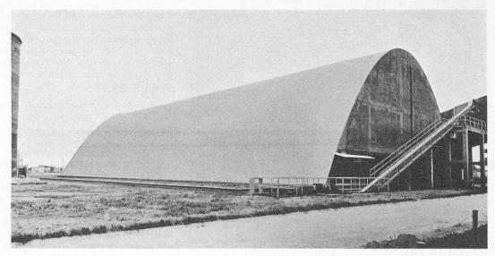
Bild 14. Lagerschuppen von parabolischem Querschnitt für Düngemittelrohstoffe. Längs- und stirnseitig davon verlaufen in eleganter Linienführung die Kettentransporteure zur Fabrikationshalle
