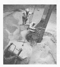
Bild 9 (links). Zuführung der Materialreste zum Aufnahmefuss des SKT-Förderers. Hiezu werden von Hand geführte Schrapperschaufeln verwendet
