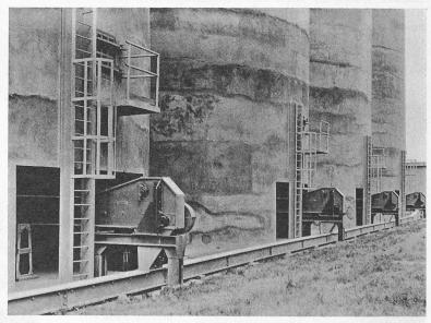
Bild 13. Die vier 15 m langen Ausziehtransporteure speisen wahlweise einen  $100\,\mathrm{m}$  langen horizontalen Kettenförderer. Dieser ist direkt über dem Erdboden verlegt
