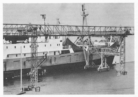
Bild 6. Schiffsbeladeanlage für Kalisalz im Hafen von Haifa, Als Förderelemente dienen ausschliesslich geschlossene Kettentransporteure
