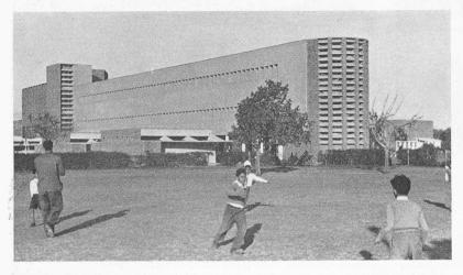
Bild 16. Zum Sonnenschutz horizontale Lamellen an der Südseite, vertikale Lamellen an der Westseite (Englische Schule von Meadi)
