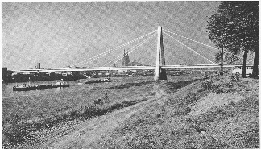
Bild 1. Die Severinsbrücke in Köln von der Oberstromseite
