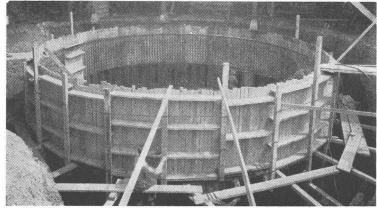
Betontank von 250 000 l im Bau
