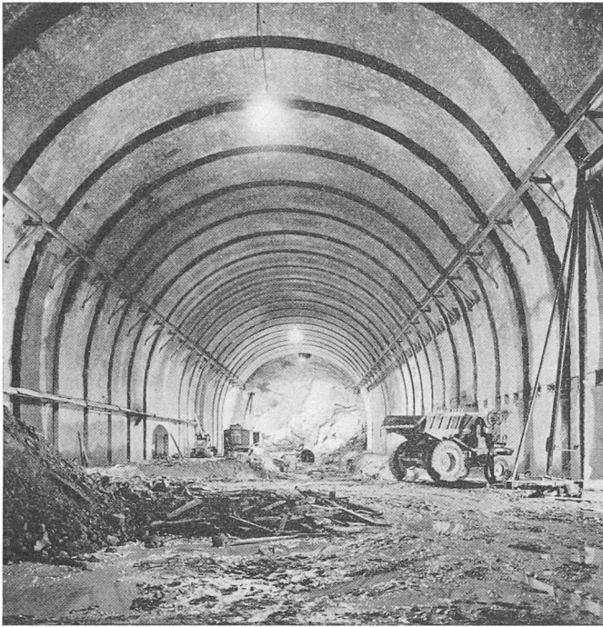
Die Maschinenkaverne Ferrera im Rohbau, Länge 143,5 m, Breite 29 m, Höhe 24 m (Photo G. Vetter, Zürich)
