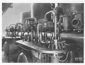
Bild 20. In die Anlage eingebaute Expansionsturbinen
