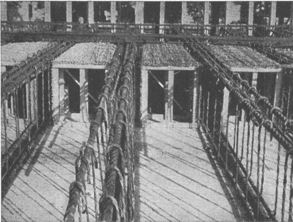
**ROBUR Schilfrohrzellen für Betondecken**
