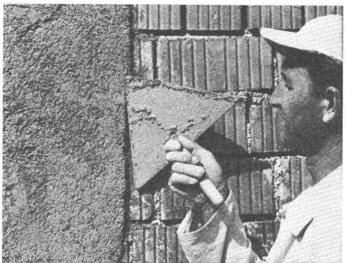
Putzmörtel ohne TRICOSAL-WA lässt sich nur mit Mühe zu einem zufriedenstellenden Putz verarbeiten.
