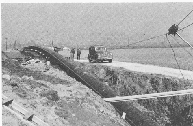
Bild 2. Der Düker zu Beginn des Einziehvorganges
