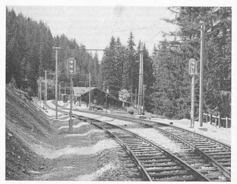
Bild 5. Die Station Cavadürli aus Südosten. Im Vordergrund die beiden Gleis-Ausfahrsignale C<sup>1</sup> und C<sup>3</sup>, hinten die mit Weichenschlüssel gesicherte Anschlussweiche mit einem abgestellten Bahndienst-Fahrzeug
