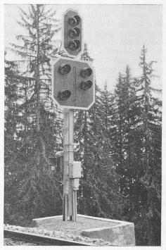
Bild 6. Einfahrsignal D  $^{1/3}$  mit angebautem Vorsignal B\*. An der Rückseite des Signalmastes Telephonapparat zur allfälligen Verständigung zwischen Zugspersonal und Fahrdienstleiter.
