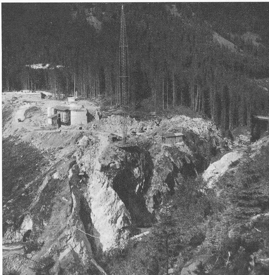
Bild 1. Sperrstelle Sufers aus Süden, Anfang Juli 1960. Im Vordergrund der linksufrige Fundamentschlitz für die Bogenmauer in der Hinterrheinschlucht. Links der Einlauf des Umleitstollens. Auf dem Crestawaldrücken der 6-t-Derrick mit 60 m grösster Ausladung für die Staumauerbetonierung. Die Betonmischanlage ist links an einen bereits erstellten Teil der bergseitigen Wand der Hochwasserentlastung angelehnt, deren Ablaufrinne sich im Aushub befindet. Ganz hinten links ein Stück der aus dem Staugebiet verlegten neuen Kantonsstrasse, bis zu welcher sich der niedrige Flügeldamm auf dem Crestawaldrücken erstreckt
