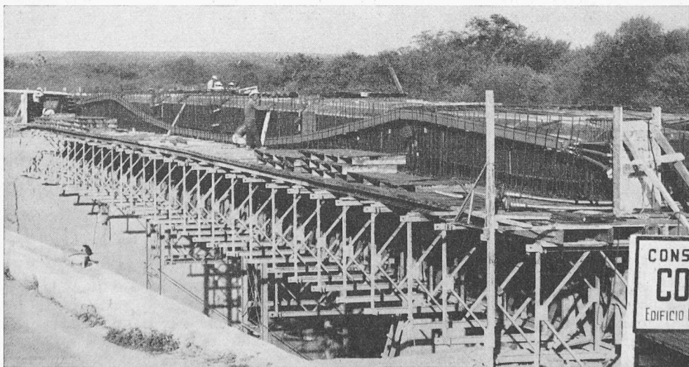
Bild 3. Leergestüt aus Bailey-Elementen. Brückenschalung aus einzelnen Tafeln zusammengesetzt. Beim vorderen Trägerende zwei Querkabel zu erkennen, Links unten Anfang der alten Brücke, deren Mittelfeld weggeschwemmt war
