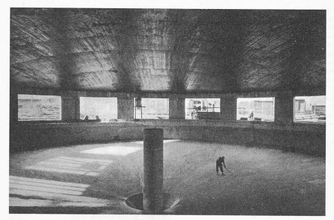
Bild 3. Dorreneindickerraum mit Auflagerzapfen des Krählwerkes und Oeffnung zum Schlammkanal. Darüber die Kuppel, Bild 2, die zugleich als Absetzbecken für den Kühltunnel dient
