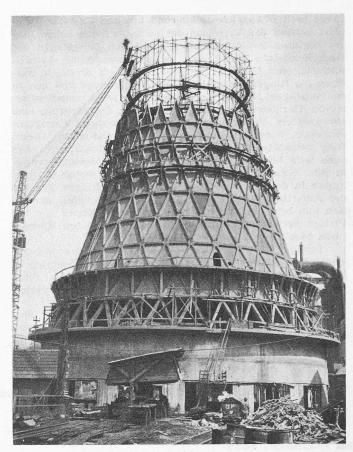
Bild 4. Montage des Kühlturmes; Einsetzen eines dreieckförmigen Fertigelementes
