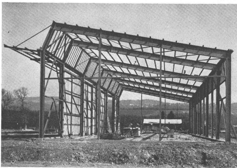
Einstellhalle für Genie-Waffenplatz Bremgarten (Dir. der Eidg. Bauten)
