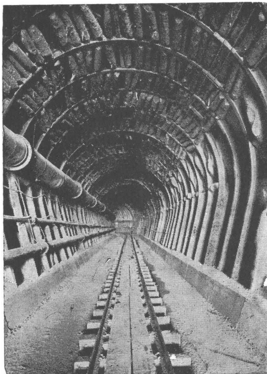
Stollen mit Stahleinbau in gebrächem Fels
