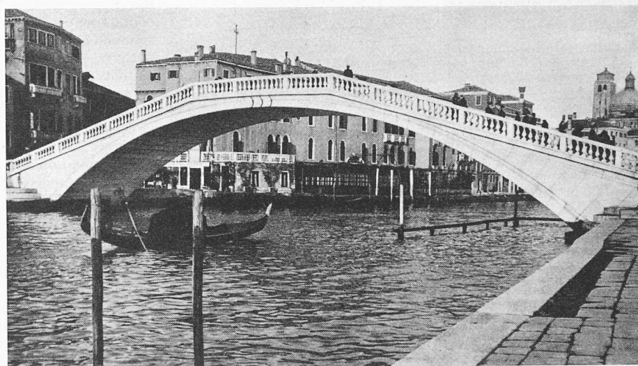
Bild 12. Scalzi-Brücke, in klassischer Bauweise aus Kalksteinquadern ausgeführt und auf Pressbeton-Orbspfähle abgestellt (Blick in den Canal Grande von S. Simeone Piccolo aus; der Bahnhof liegt links)
