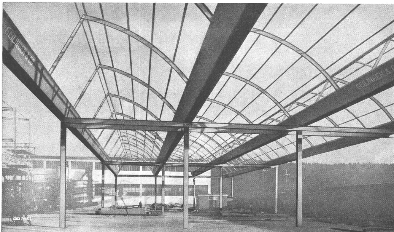
Shedkonstruktion mit rinnenförmigen Hauptträgern (+ Pat. angem.)
