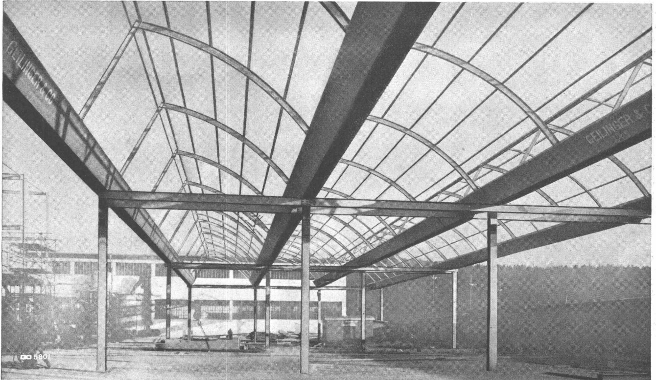
Shedkonstruktion mit rinnenförmigen Hauptträgern (+ Pat. angem.)
