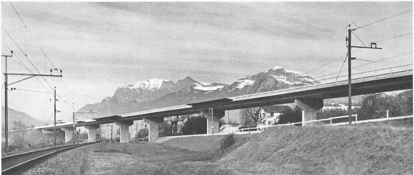
Bild 1. Gesamtaufnahme der Brücke Zizers
