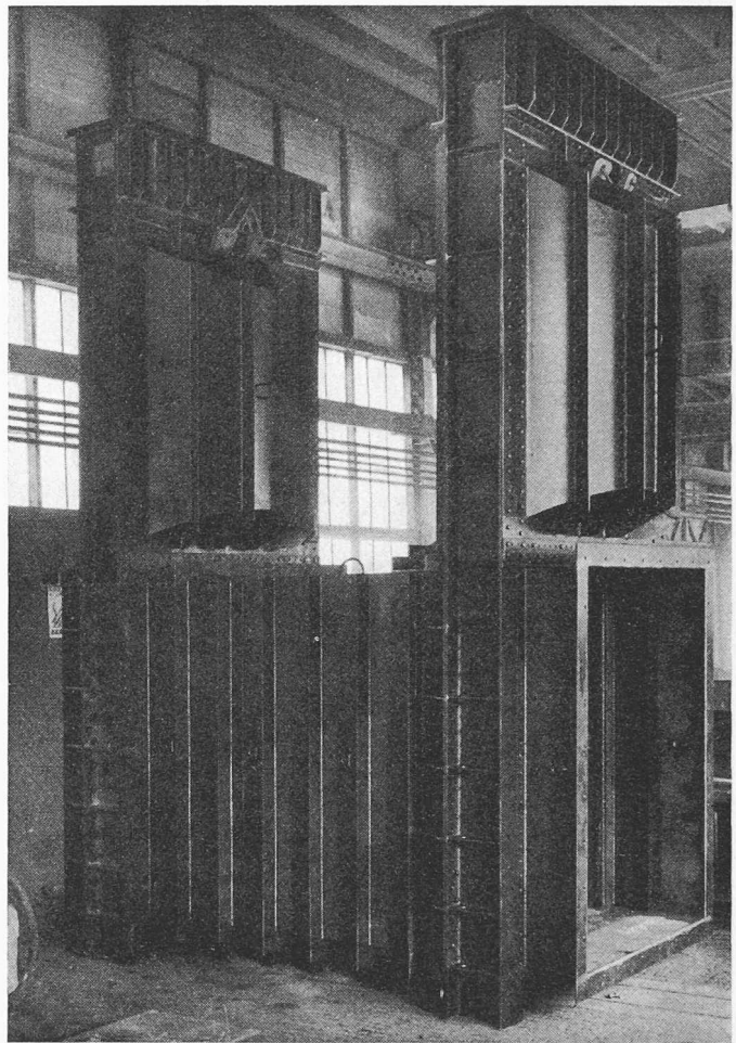
Bild 15. Mauerdurchlass des Ausgleichbeckens Bärenburg. Schützenführungen (Werkaufnahme)
