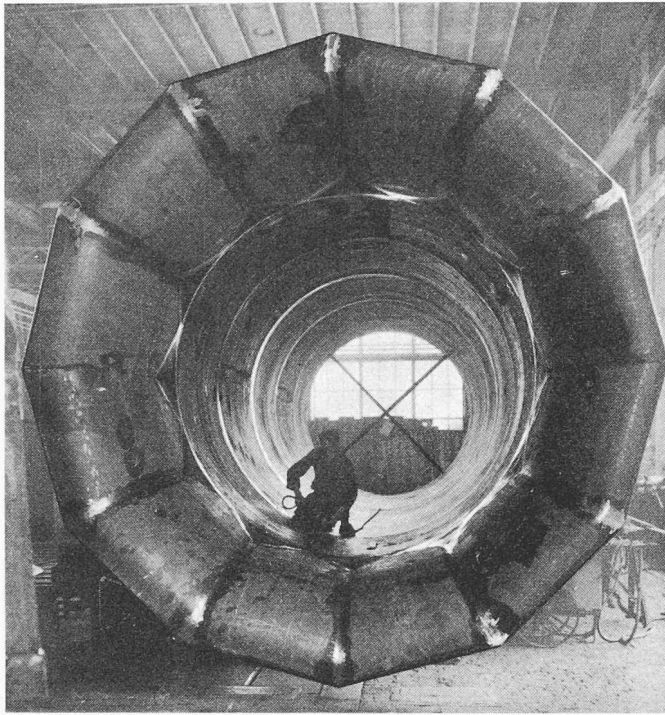
Bild 16. Einlauftrumpete zum Mauerdurchlass
