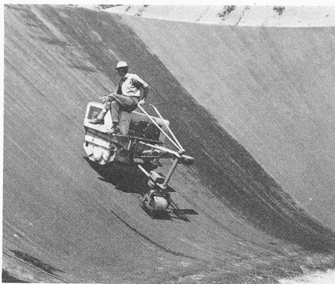
Bild 5. Einbau des Belags beim Ausgleichbecken Vissoie der Kraftwerke Gougria
