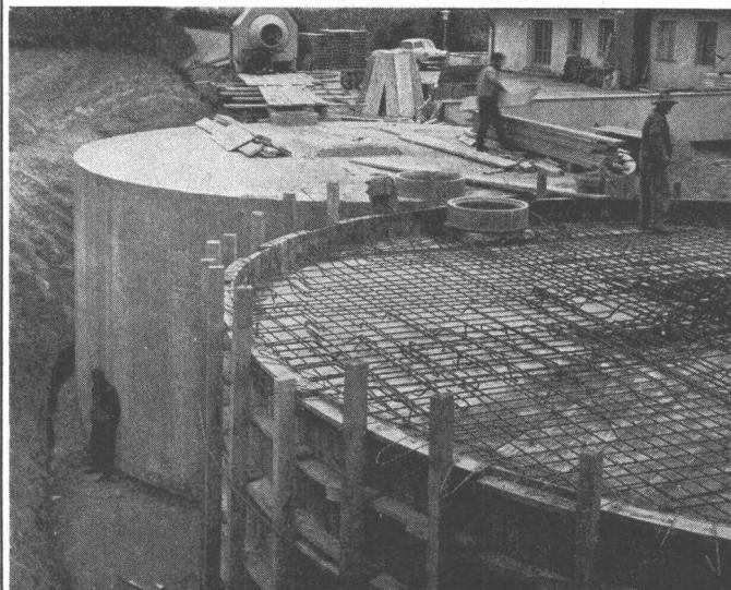
Betonbehälter für Heizöl, Inhalt 500 000 L.
