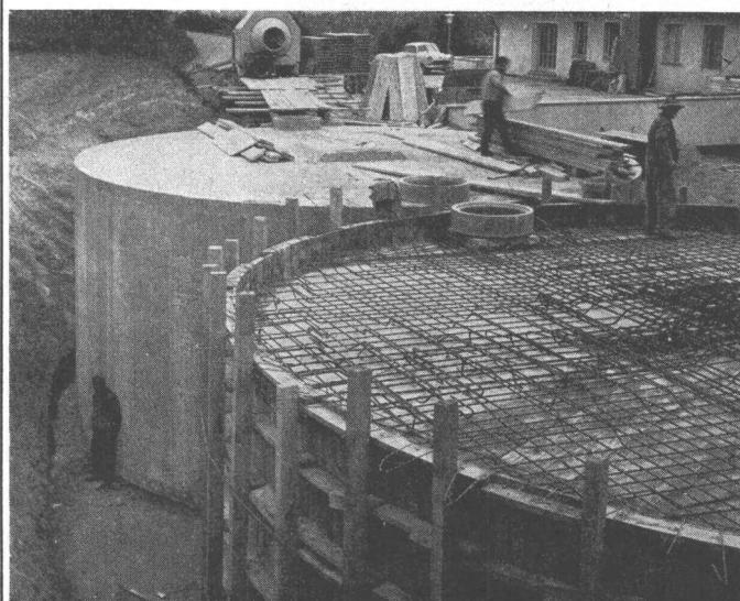
Betonbehälter für Heizöl, Inhalt 500 000 L.
