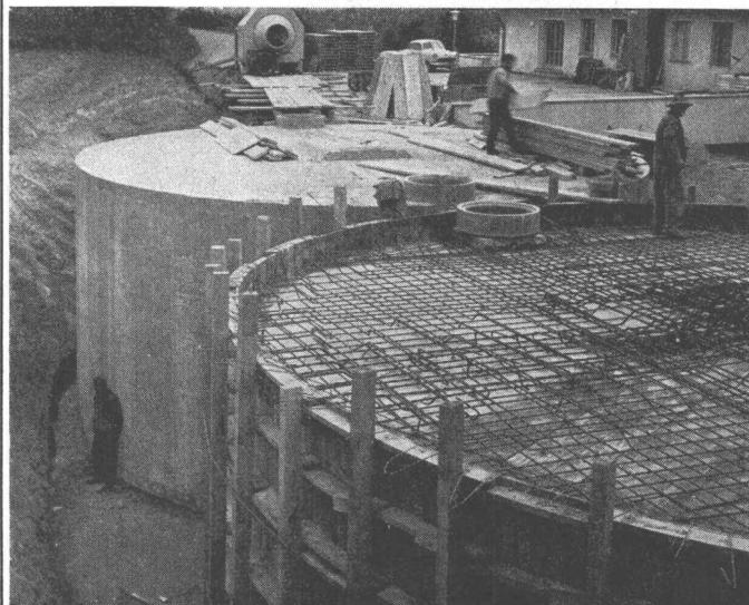
Betonbehälter für Heizöl, Inhalt 500 000 L.
