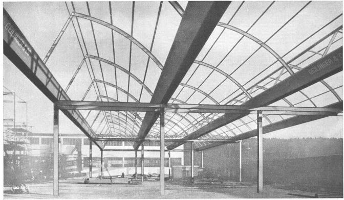
Shedkonstruktion mit rinnenförmigen Hauptträgern (+ Pat. angem.)
