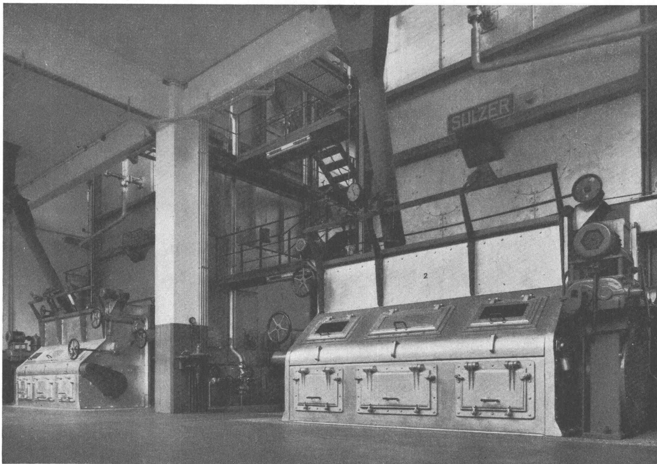
Mitteldruck-Strahlungskesselanlage in einer Zellulosefabrik der Schweiz, umfassend 2 Einheiten für je 20/25 t/h, 50 atü, 460 °C
