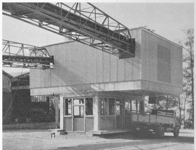
Bild 15. Bandbrücken von den Dosieranlagen zur Verladestation. Im Ueberbau der Letztgenannten befinden sich die vollautomatischen Durchlaufs-Zwangsmischer
