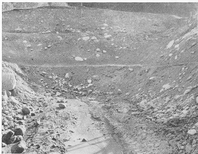
Bild 3. Herbst 1957; grosser, mit Trax ausgeführter Sondierschlitz
