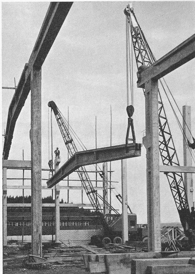
Bild 24. Versetzen eines vorgespannten Riegels
