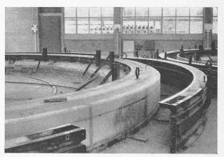
Bild 43. Tübbing mit losgelöster Schalung
