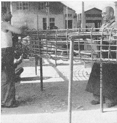
Bild 40. Binden der Tübbing-Armierungen
