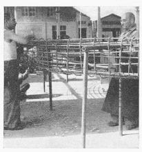
Bild 40. Binden der Tübbing-Armierungen Bild 41. Teilarmierung mit Einsätzen
