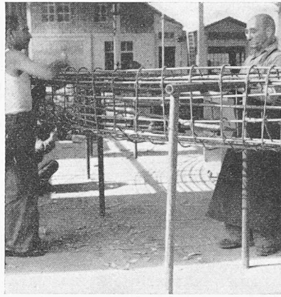
Bild 40. Binden der Tübbing-Armierungen
