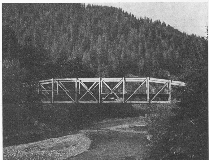
Bild 1. Alte Glennerbrücke der Rh. B. bei Ilanz, erbaut 1902
