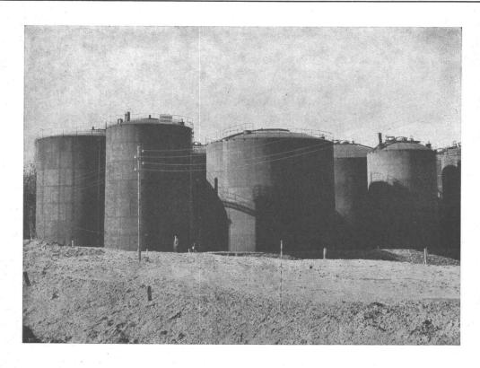
Série de 7 réservoirs pour stockage de mazout et de benzine avec fonds brevetés Giovanola. Capacité totale 16 000 m³. Réservoirs de benzine construits pour une pression de service de 0,2 atm.
