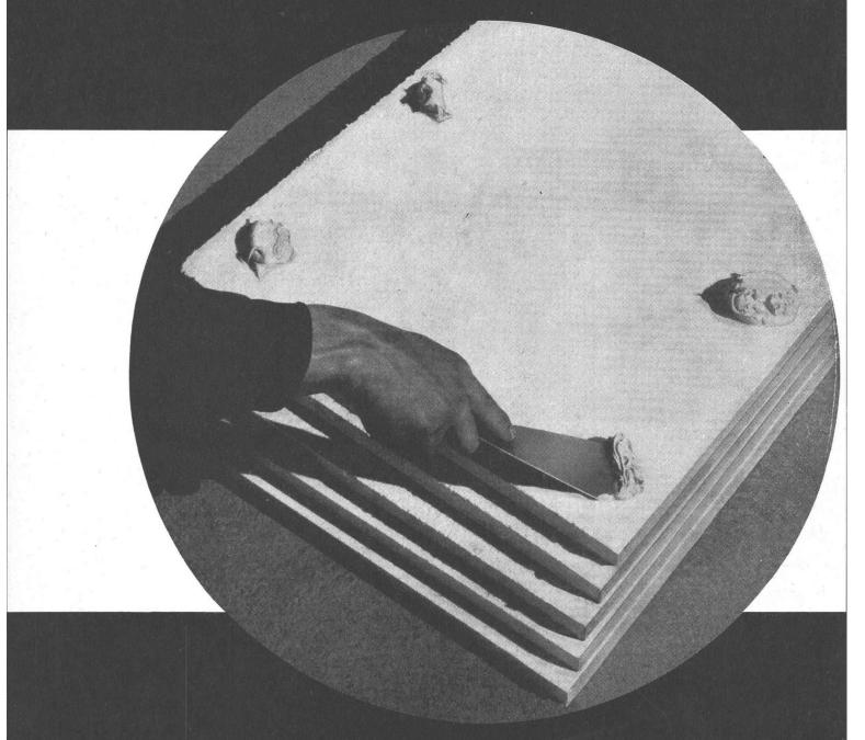
ein sofort haftender Kitt zum Verlegen von Sagex, Wannerit, Syntopor, Alporit auf Beton, Mauerwerk, Holz usw. Hohe Anfangsfestigkeit
