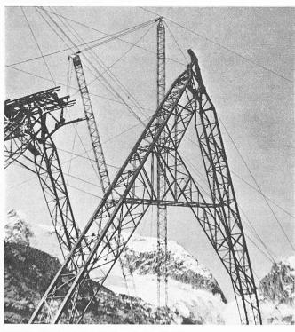
Bild 8. Montage des Joches A der Brücke
