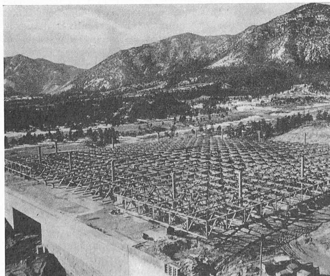
auf den vorher errichteten Stahlstützen angebracht waren, bis in die endgültige Lage gehoben und befestigt. Entlang jeder der vier Seiten befinden sich vier solcher Stützen. Es entstand damit ein stützenfreier Raum von 81 × 81 m, das Dach kragt allseitig um 6,5 m frei vor. Für das Schweißen verwendete man neuartige Lincoln-Electric-Schnellelektroden aus Eisenpulver («Eng. News-Record» 23. 1. 58).
