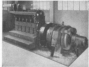
Diesel-Generatorgruppe auf schwingungsfreiem Fundament
