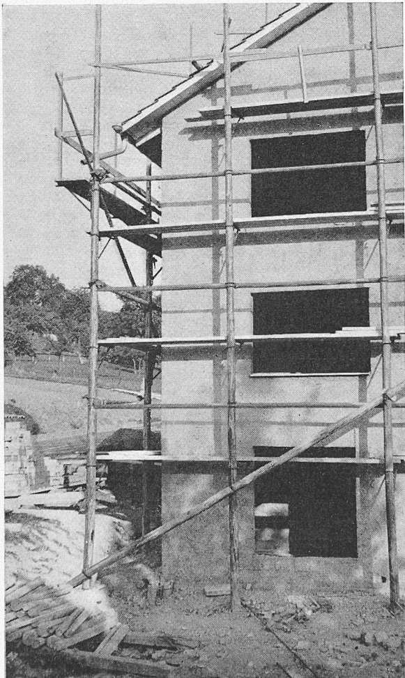
Gerüst mit Laufgang für Dachgesimsarbeiten
