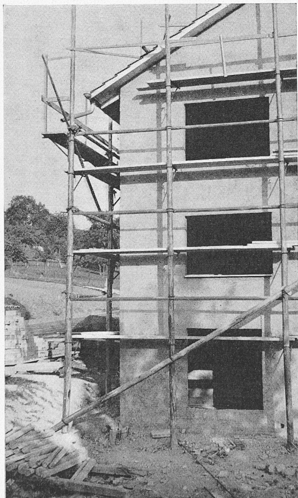
Gerüst mit Laufgang für Dachgesimsarbeiten
