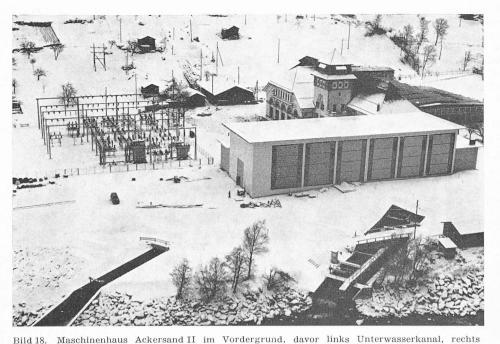
Bild 18. Maschinenhaus Ackersand II im Vordergrund, davor links Unterwasserkanal, rechts Unterwasserkanal des hinten sichtbaren Maschinenhauses Ackersand I (mit Turm und Steildach) Hinten links neue Schaltanlage
