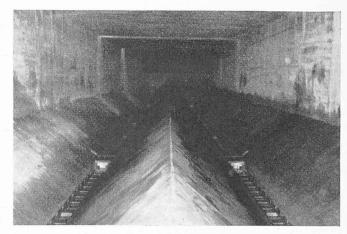
Bild 6. Entsandungsanlage, Doppelkammer m. Sandabzugvorrichtungen
