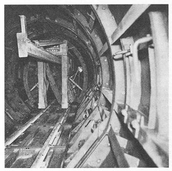
Bild 13. Gleitschalung für die Stollenverkleidung
