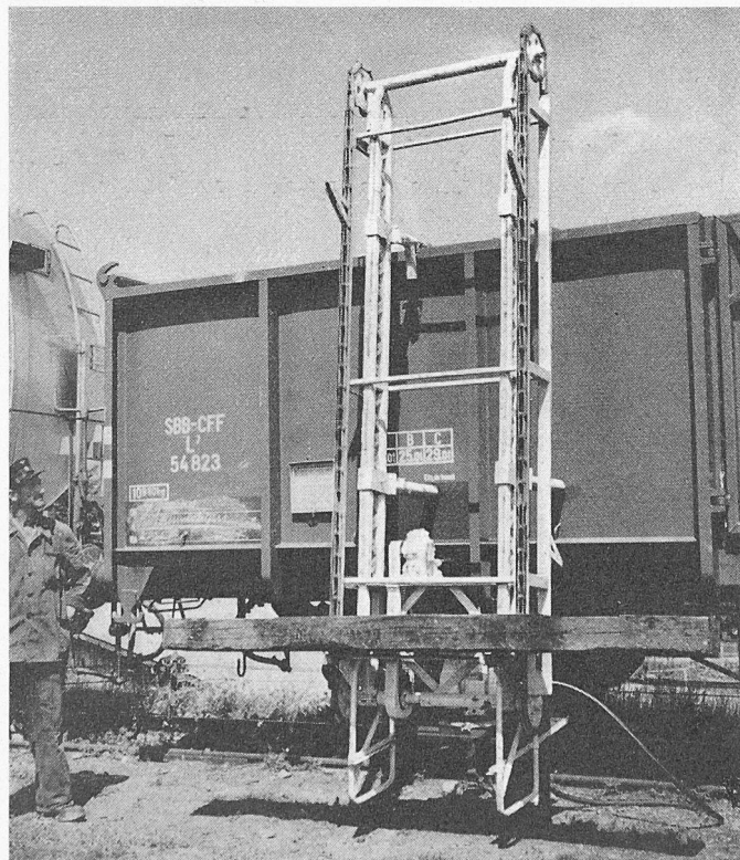
Bild 17. Schwellenaufłademaschine
