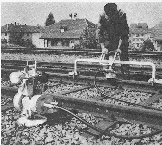
Bild 15. Schmirgelmaschine mit biegsamer Welle
