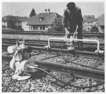
Bild 15. Schmirgelmaschine mit biegsamer Welle
