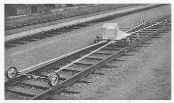
Bild 22. Leichter Messroller für Abnahme grösserer Geleisearbeiten
