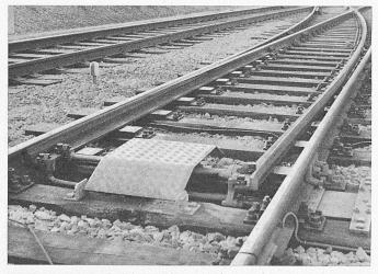
Bild 7. Neue einfache Weiche mit Rippenplattenbefestigung und Federzungen
