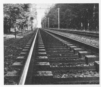
Bild 5. Versuchsstrecke mit Betonschwellen verschiedener Herkunft zwischen Aarau und Rupperswil
