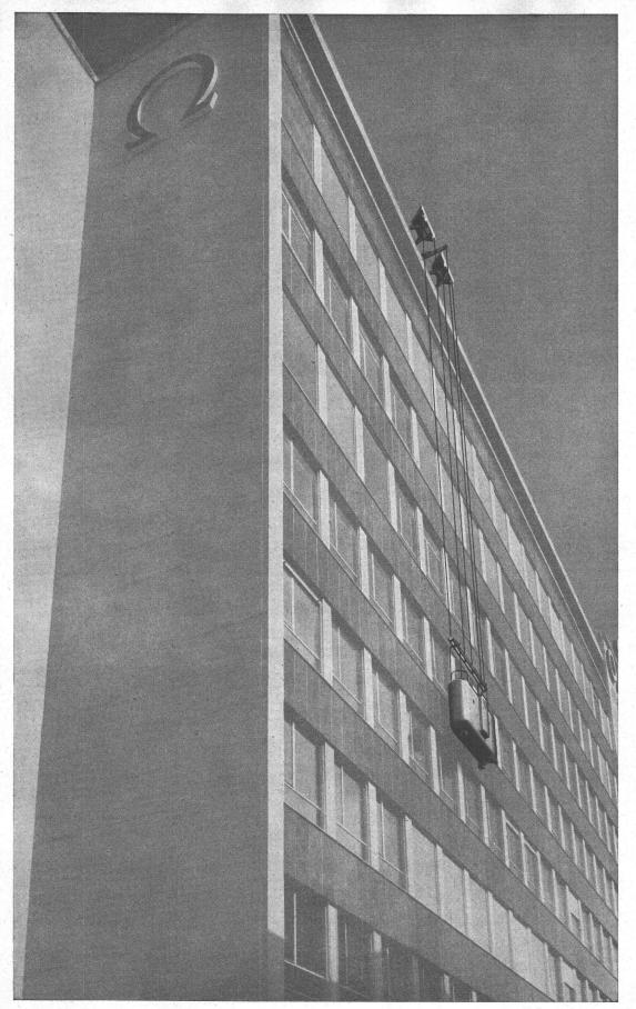
Von der Arbeitsbühne aus durch Druckknopfsteuerung vertikal und horizontal verschiebbare Fensterreinigungsanlage
